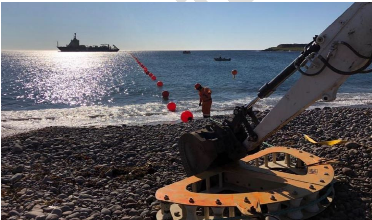
Figure 6 : Exemple de quadrant utilisé pour le tirage du câble
